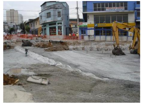
Figura 3. Reaterro sobre laje da estação na região da Bom Pastor com Greenfeld; vista para norte.
