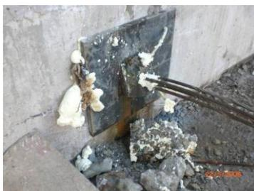
Figura 15. Cabeça de tirante tratada com espuma expansiva de poliuretano.
