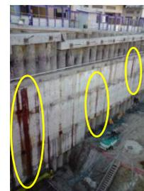
Figura 17. Fluxo de água através da vedação da cabeça do tirante.
